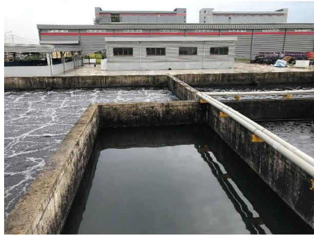
Hệ thống XLNT, công suất 800 m 3 /ngày đêm
