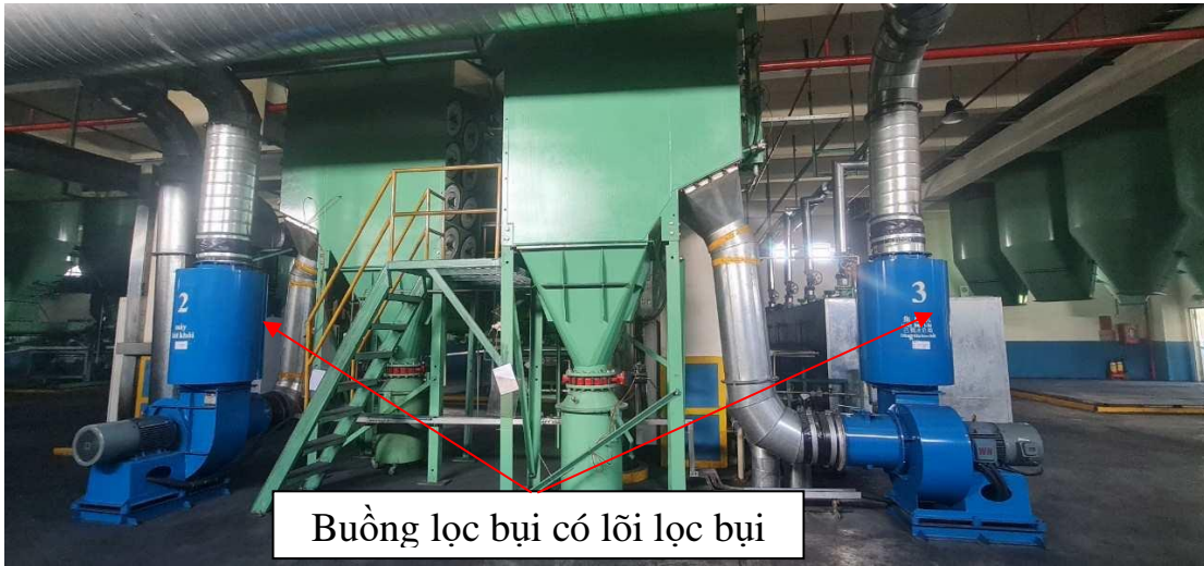
Hệ thống lọc bụi, mùi, khí thải tại lầu 2
