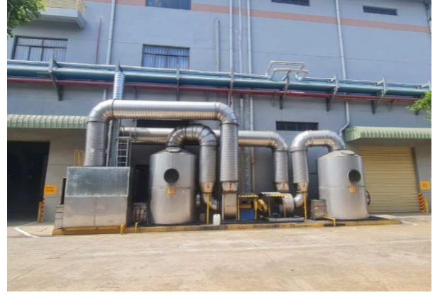
Cụm hệ thống thu gom, xử lý bụi, khí thải, mùi số 2
