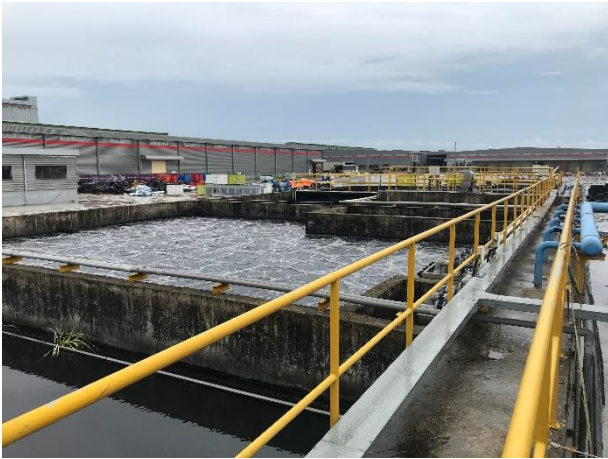
Hệ thống XLNT, công suất 800 m 3 /ngày đêm
