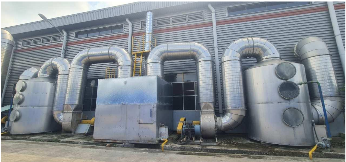
Cụm 2 hệ thống thu gom, xử lý bụi, mùi tại công đoạn ép vỏ (Xưởng vỏ xe ô tô)
