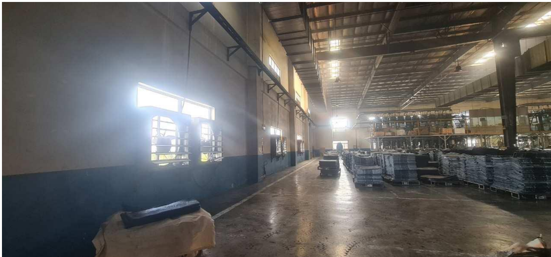
Hệ thống quạt hút thông gió tại lầu 1 Xưởng luyện keo
