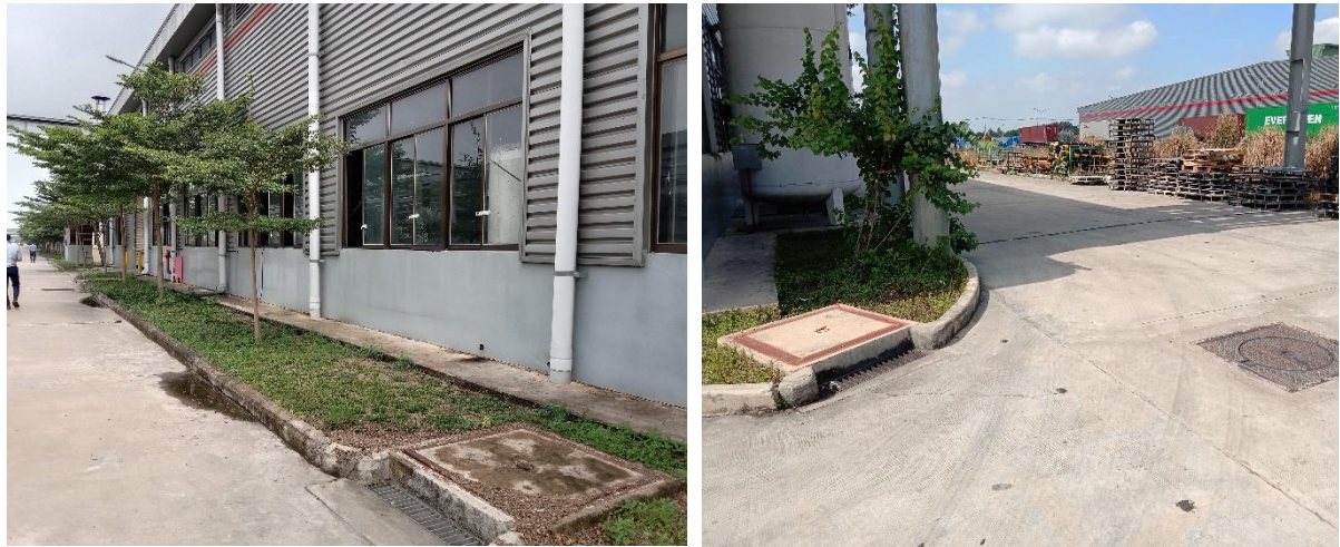
Hình 3. Hệ thống thu gom, tiêu thoát nước mưa tại Nhà máy Giang Điền - Công ty Cao su Kenda (Việt Nam)
