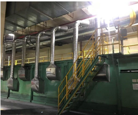
Hệ thống chụp hút, đường ống thu gom bụi, mùi từ công đoạn nạp liệu và luyện keo (nhào trộn, cán luyện) tại tầng trệt
