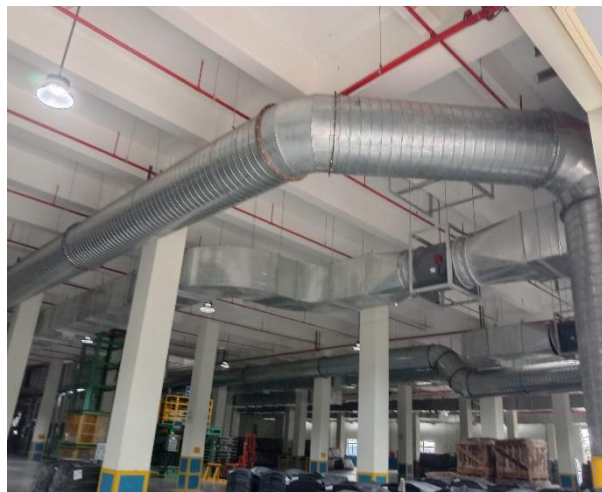
Hệ thống chụp hút, đường ống thu gom bụi, mùi từ công đoạn nạp liệu và luyện keo (nhào trộn, cán luyện) tại tầng trệt
