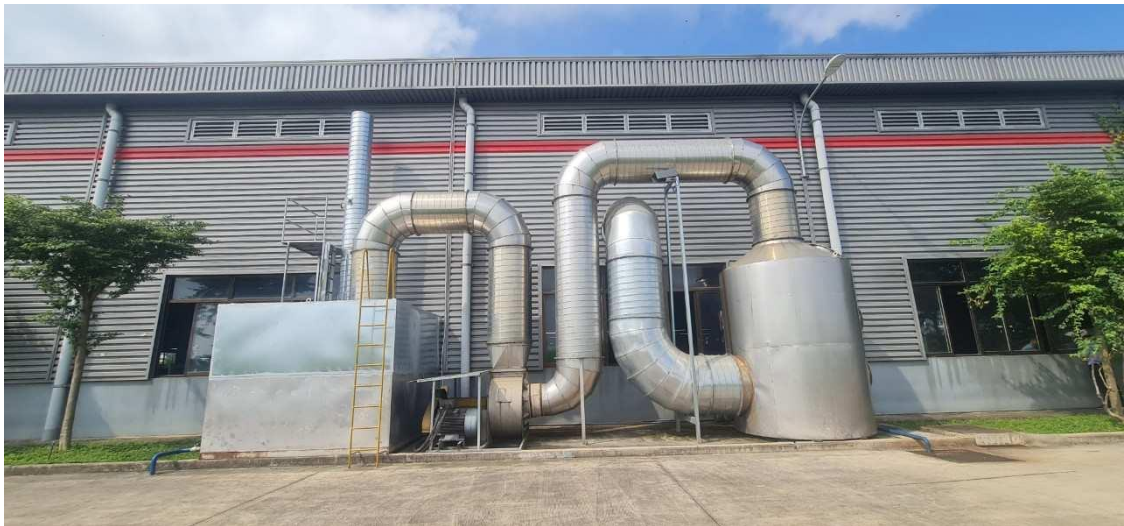
Hệ thống thu gom, xử lý bụi, mùi tại công đoạn ép vỏ (Xưởng vỏ xe máy, xe công nghiệp)
